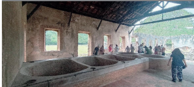
Figura 3.- Fotografía de la casa de calderas del Ingenio Boca de Nigua, Santo Domingo, República Dominicana, del siglo XVII. En la imagen se aprecia el tren de fogones en donde se colocaban las calderas de cocimiento del jugo de la caña de azúcar. Fuente: Autoría propia.
