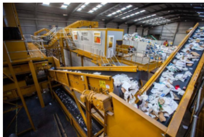
Figura 3. Planta tratadora de residuos. Fuente: MYCSA. Obtenido de: https://mycsamulder.es/como-crear-planta-tratamiento-residuos-urbanos/
