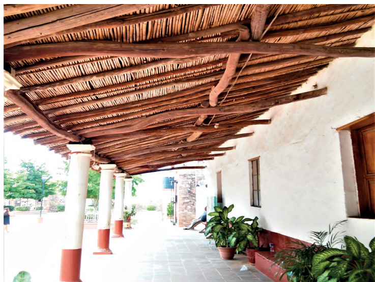
Figura 4. Uso de carrizo en sistema de cubierta, portal Notaría Parroquial Iglesia de San Juan Huetamo, Huetamo de Núñez, Tierra Caliente, Michoacán. Fuente: autoría propia.
