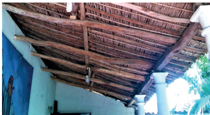
Figura 3. Uso de carrizo en sistema de cubierta, Casa Museo Morelos, Carácuaro, Tierra Caliente, Michoacán. Fuente: autoría propia.
