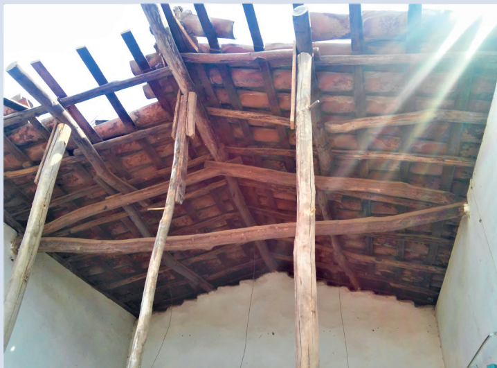
Figura 2. Ejemplo de cubierta tradicional en la arquitectura calentana. Fuente: autoría propia.
